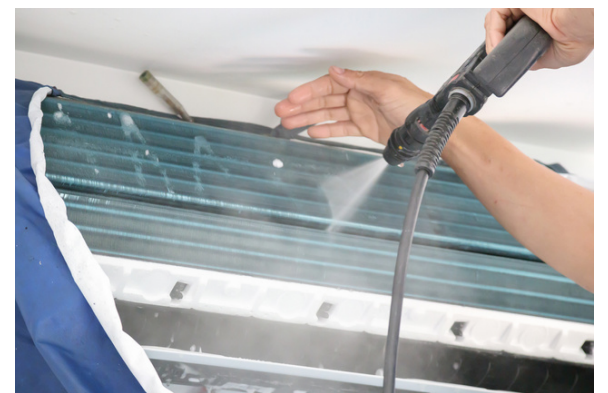
LIMPIEZA DE AIRES ACONDICIONADOS
